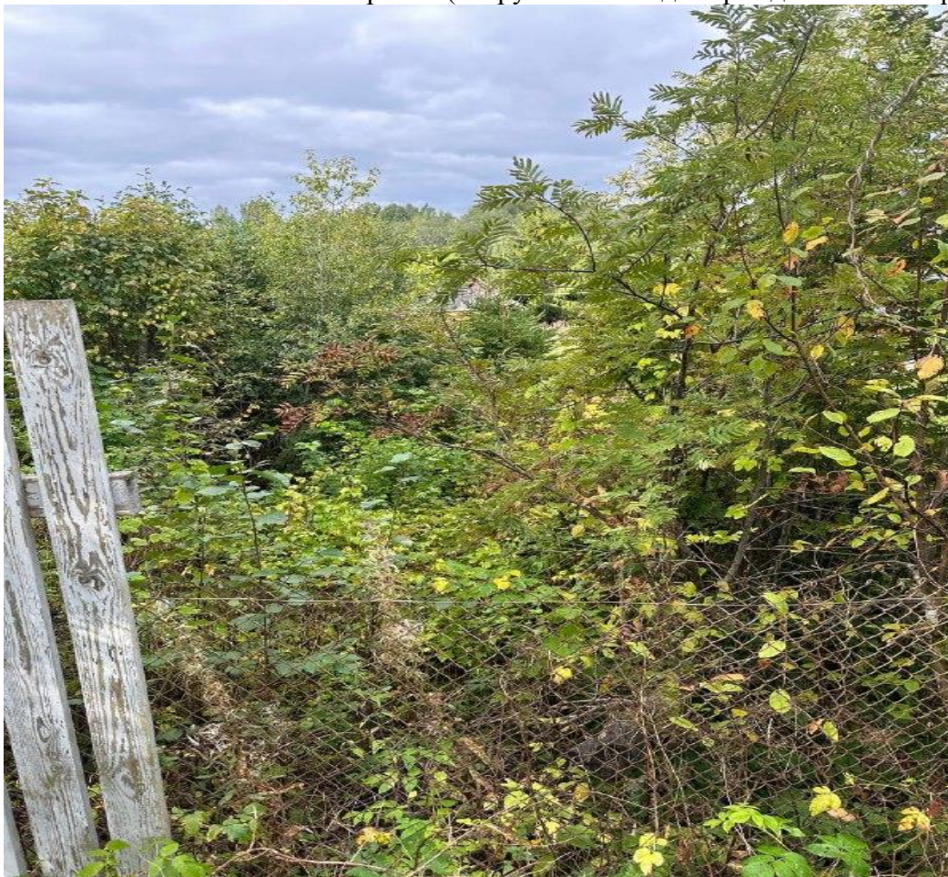
Фото № 4. Самовольная постройка (сооружение в виде ограждения сеткой рабицей)
